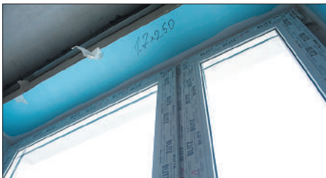
Замена окон без изменения оконного проема
