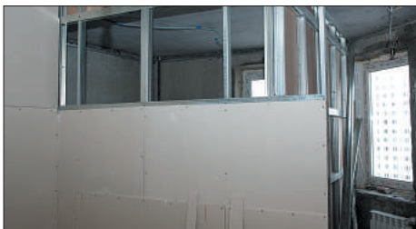
Монтаж и/или демонтаж несущих перегородок.
